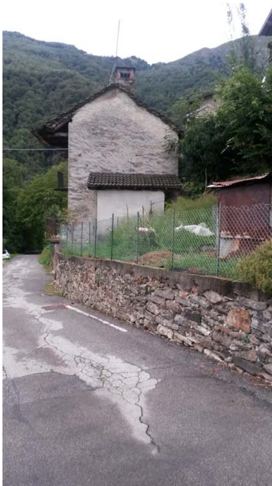
Vista laterale del fabbricato oggetto d'intervento dove sarà realizzata la torre dell'ascensore e dei muri di contenimento dei terrazzamenti antropici
